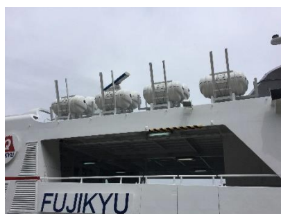
救命浮器の設置状況
