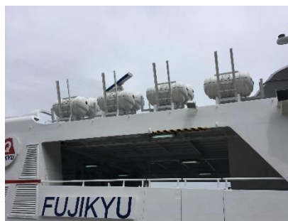
救命浮器の設置状況
