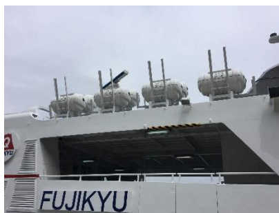
救命浮器の設置状況
